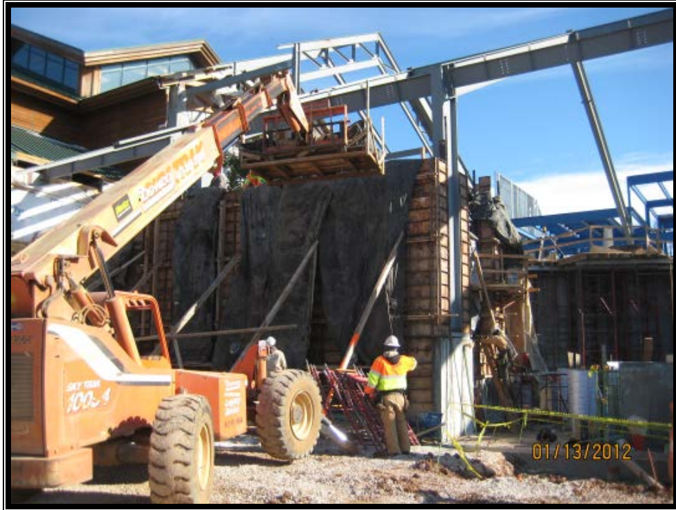
Bear Enclosure Concrete Wall Pour
