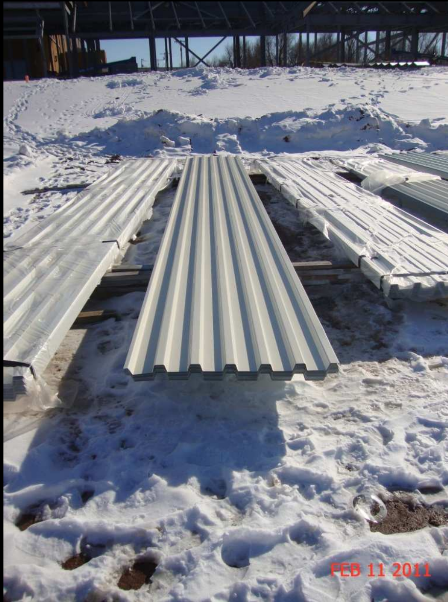
Epoxy Primer Roof Decking Holding Area
