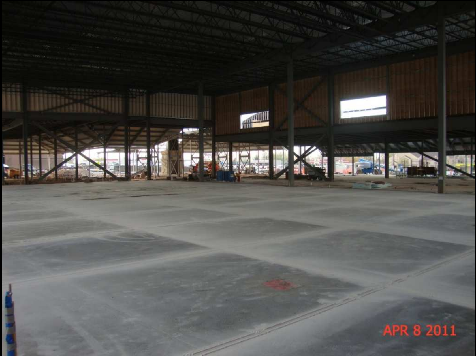
Slab Pour Expo
