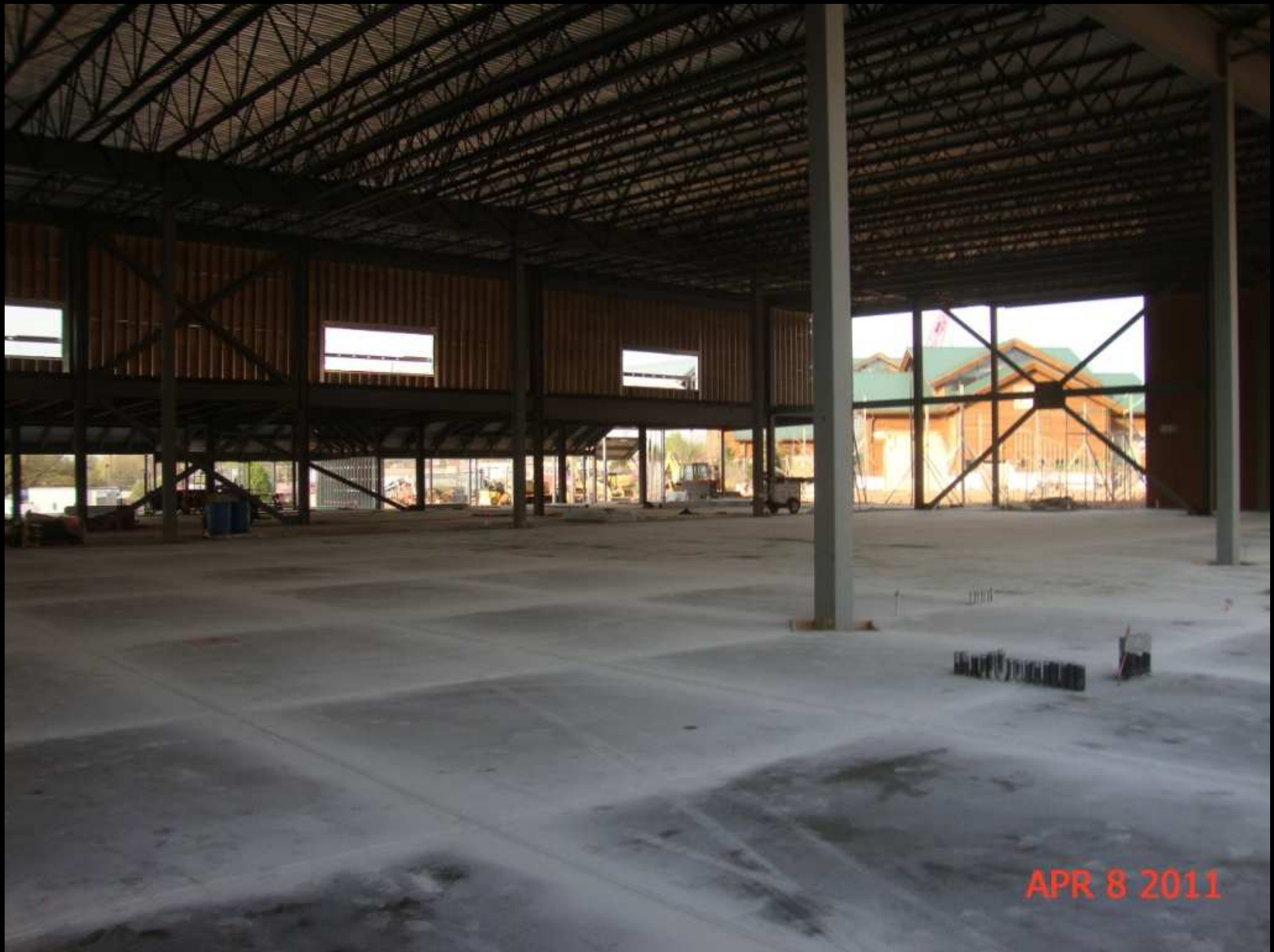
Slab Pour Expo
